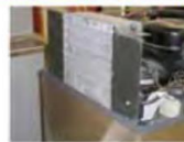
Condenseur Nettoyez les ailettes du condenseur à l'aide d'une brosse dure réservée à cet usage.
